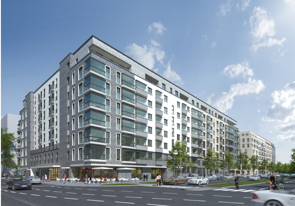
Hafenpark Quartier, Baufeld Ost
