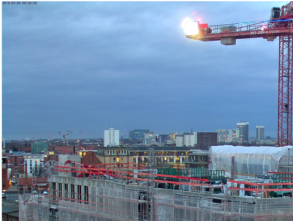
Ansicht des aktuellen Baufortschritts auf dem ehemaligen Hertie-Grundstück in Hamburg-Barmbek. Am 27. März wird das Richtfest gefeiert. Quelle: Development Partner
